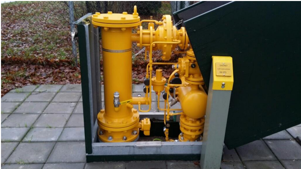
Figuur 16 De faalkans van de gasregelstations is bepaald aan de hand van de faalkansen van de individuele componenten
