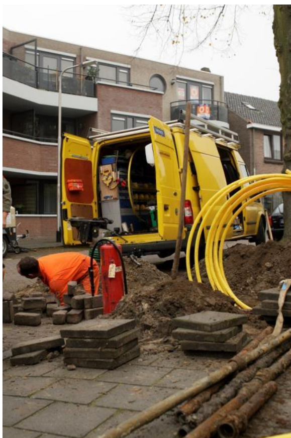
Vervangen aansluitleidingen
