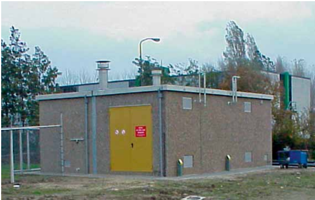
Figuur 1.2: Gasontvangstation S-309 (Cargill)
