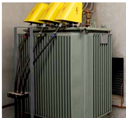
MS/LS-transformator
