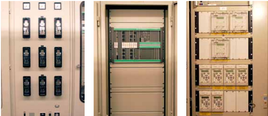
Relaiskast met elektromechanische, elektronische en digitale relais (van links naar rechts)
