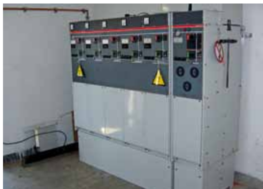
Middenspanningsschakelinstallatie
