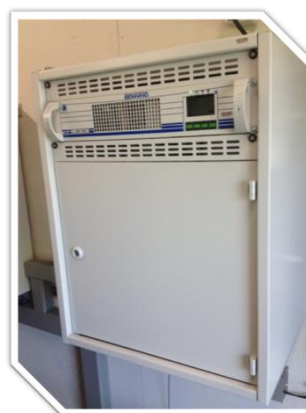
Afbeelding 16: Gelijkrichterkast t.b.v. gelijkspanningsvoorziening
