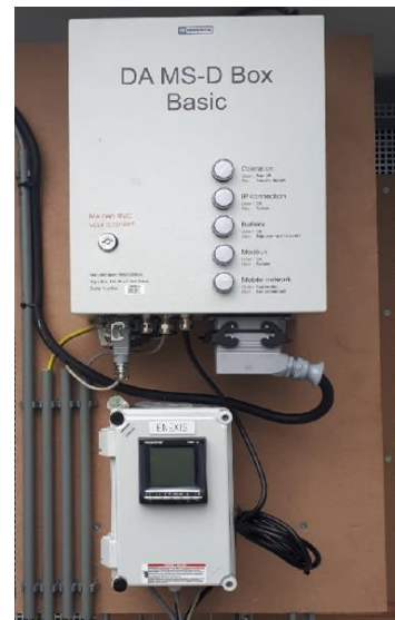
Afbeelding 15: DA-box met DIRIS-meter op montagepaneel
