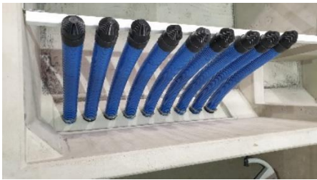
Optie: ingestorte slangtules in compactstation
