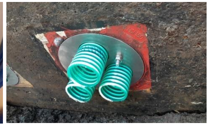
Optie: slangen in 150mm doorvoerplug
